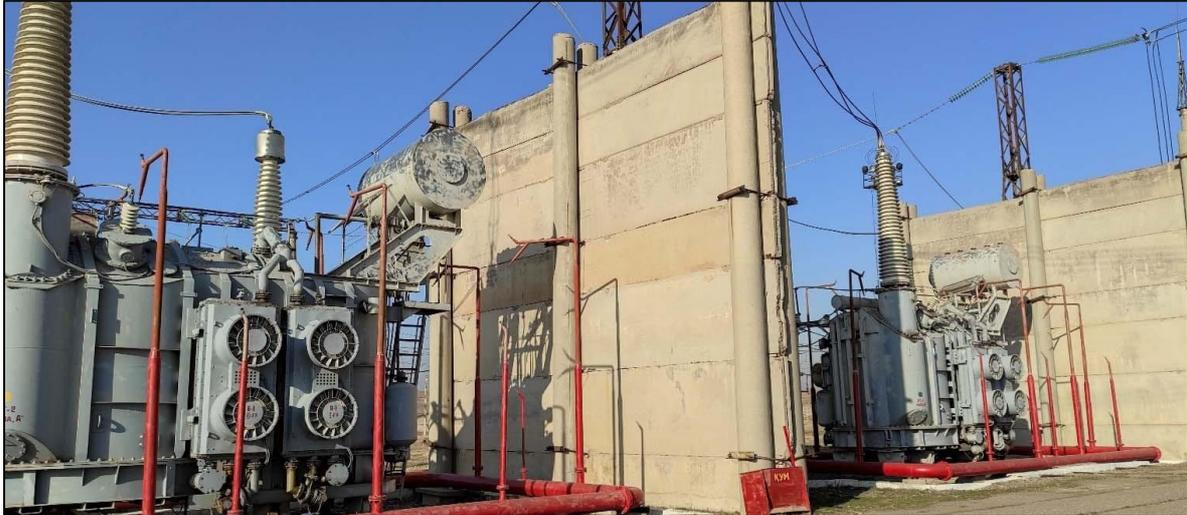
**Рисунок 2. ПС «Ташкент» однофазные АТ по 167 МВА на фазу.**
